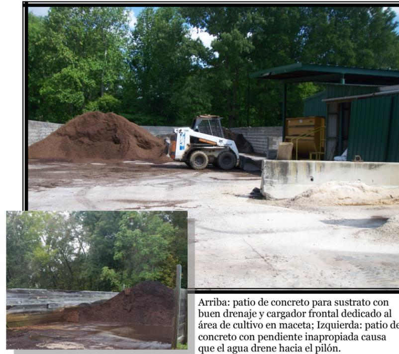
Arriba: patio de concreto para sustrato con buen drenaje y cargador frontal dedicado al área de cultivo en maceta; Izquierda: patio de concreto con pendiente inapropiada causa que el agua drene hacia el pilón.
